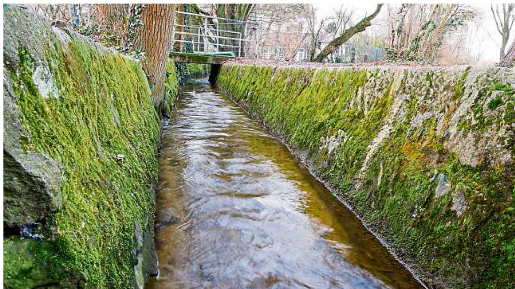
Noch in der Rudolf-Mueller-Anlage verschwindet der Darmbach im Kanal und wird in der Kläranlage mitgereinigt. Foto: Guido Schiek
